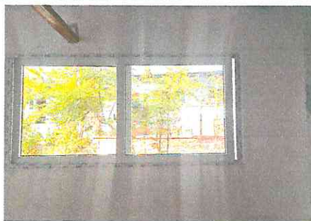
Foto 2: Se colocó una ventana de PVC para tener mayor iluminación y ventilación en un aula.
