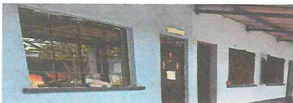
Foto 3: Se le dio mantenimiento a 3 ventanas que estaban dañadas.
