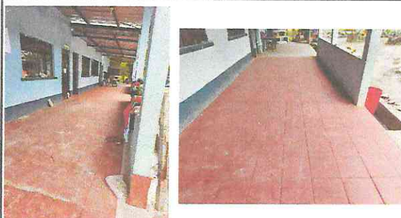
Foto 6: Se colocó piso cerámico en el pasillo o corredor ya que solo tenía cemento.
