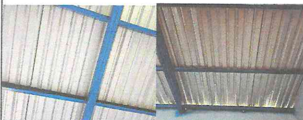
Foto 5: Se sustituyó la lámina en 2 aulas por lámina troquelada Aluzinc.
