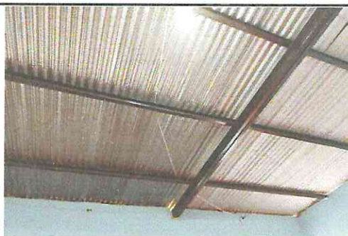
Foto 4: Se lijó y pintó la estructura metálica de 2 aulas para tener mayor durabilidad.
