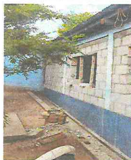
Foto 1: Se selló una ventana con block para convertir parte del pasillo en aula.
